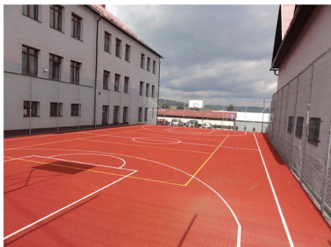
Boisko przy Zespole Szkół z ogrodzeniem
